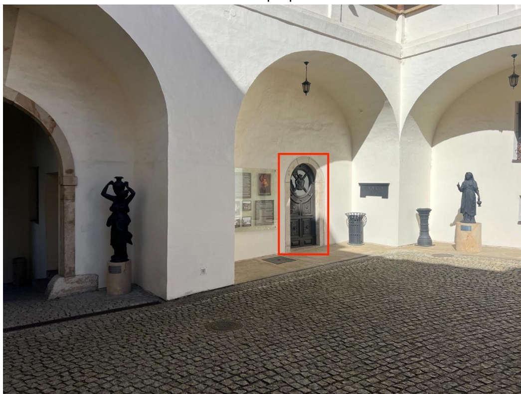
Foto 5: Vstup k plošině
